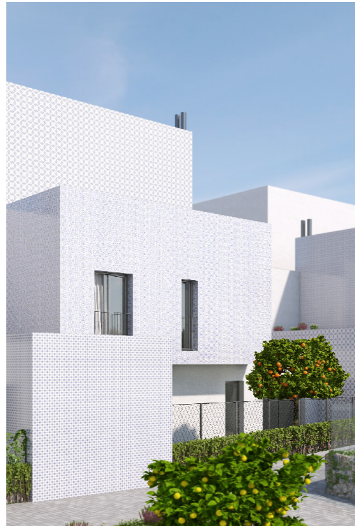
Fachada. Azulejos vidriados + monocapa Facade. Mixed tiling + single layer coating
